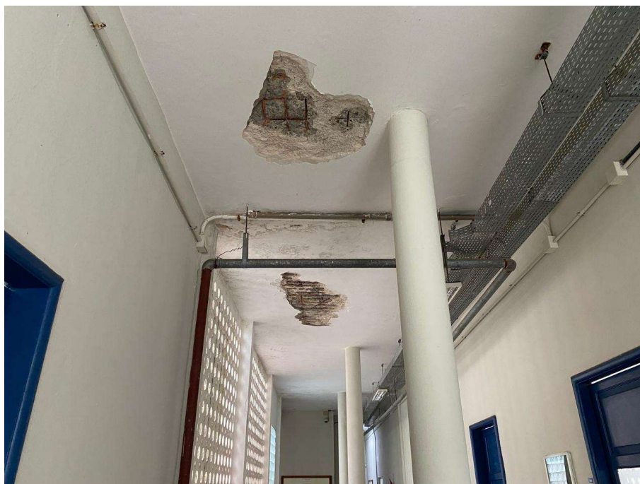
Figura 06 – Manifestações patológicas em laje sobre “CIRC. 16” – Pavimento Térreo;
